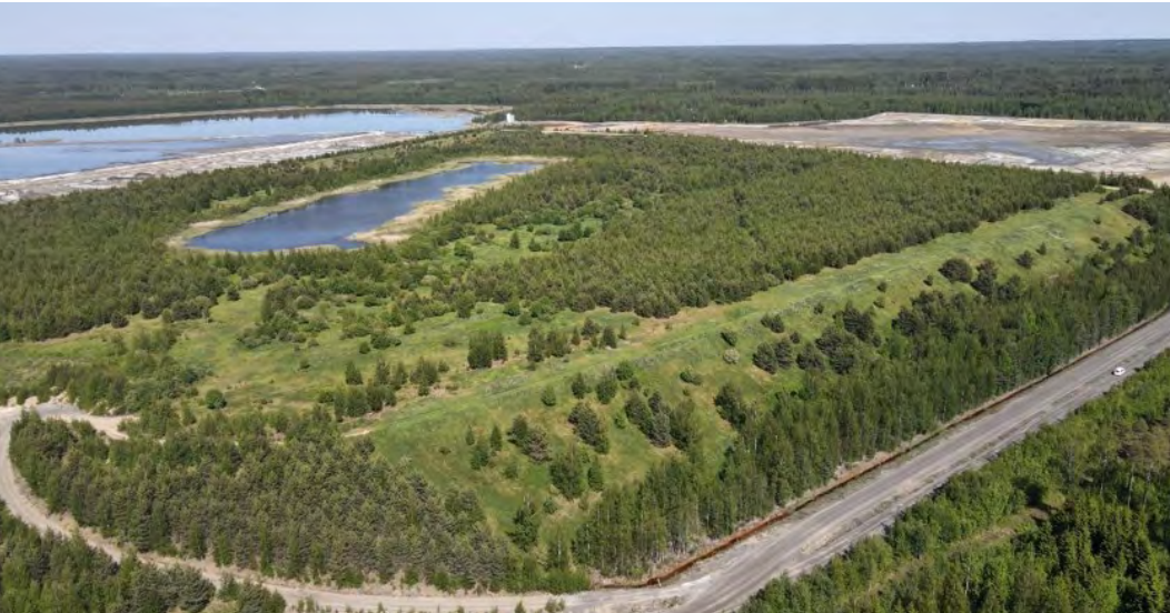
En la foto de arriba: Estanque A de la mina Pyhäsalmi en el año 2023 luego de su rehabilitación
